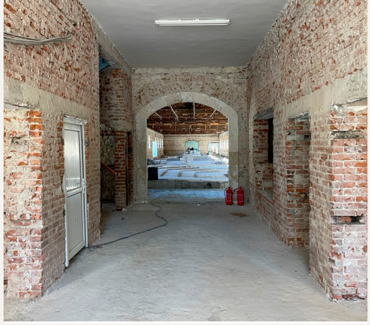
16. Edirne Süvari Kışlası'nın bloklara geçişi sağlayan girişlerden bir örnek
