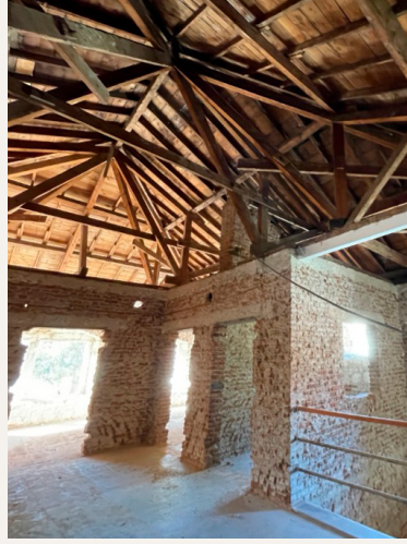
22. – 23. Edirne Süvari Kışlası, doğuya yönelen blokların ahşap kuruluşlu örtü sistemi
