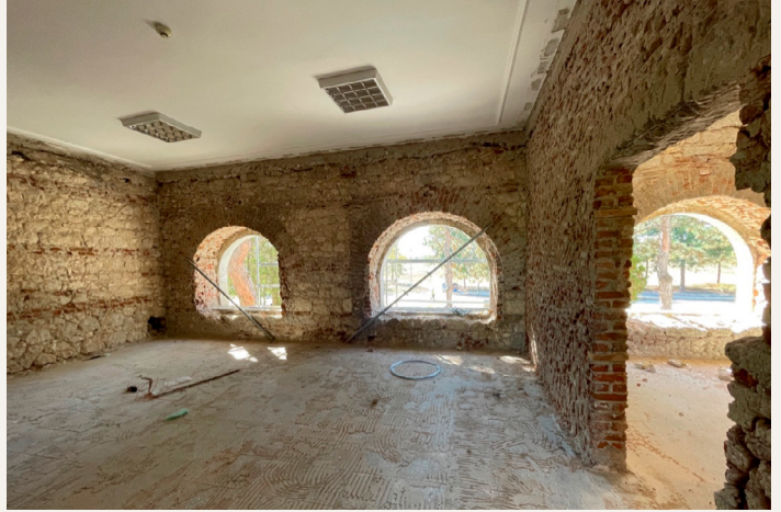
28. Edirne Süvari Kışlası, batı kanadının üst katındaki mekânlardan bir diğer görünüm
