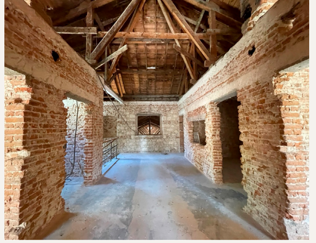
24. Edirne Süvari Kışlası, batı bloğun üst katının mekân taksimatı ve ahşap kuruluşlu örtü sisteminden detay
