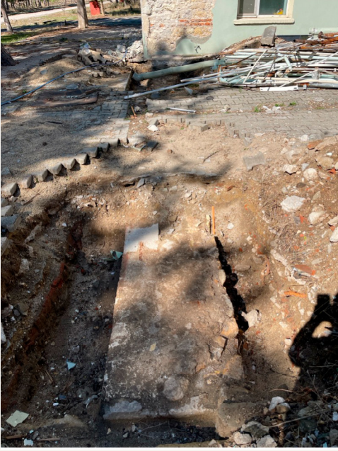
15. Edirne Süvari Kışlası'nın kuzey bloğu ile batı bloğu arasındaki geçite ait temel kalıntısı
