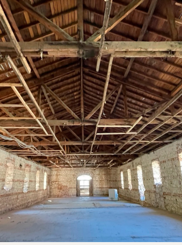
22. – 23. Edirne Süvari Kışlası, doğuya yönelen blokların ahşap kuruluşlu örtü sistemi
