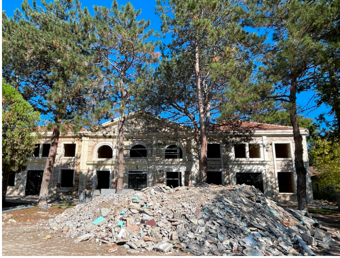
7. Edirne Süvari Kışlası'nın batı (ana) cephesinin görünümü
