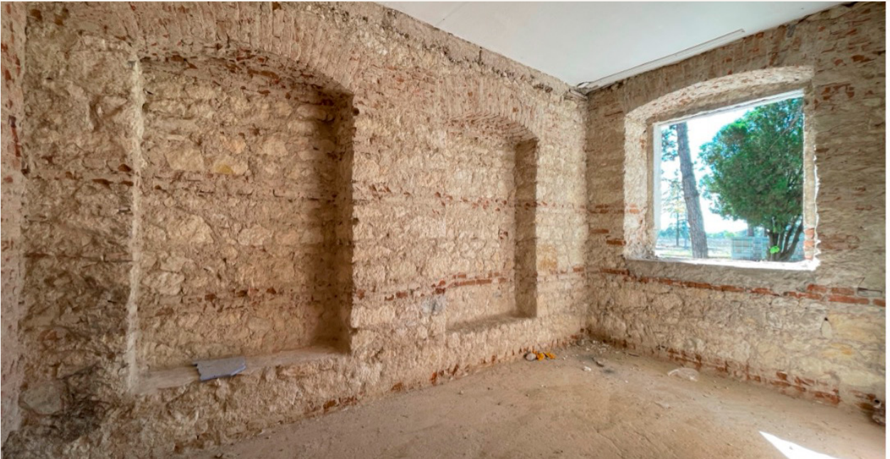
17. Edirne Süvari Kışlası'nın batı kanadının birinci katında bulunan mekânlardan bir görünüm
