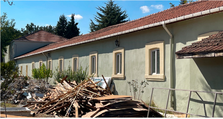
29. Edirne Süvari Kışlası, kuzeye yönelen blokların yan cephelerinden bir görünüm
