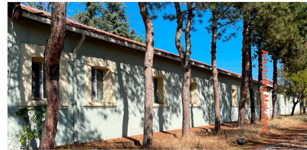
14. Edirne Süvari Kışlası'nın güney (U'nun güney kolu) bloğunun güney cephesi
