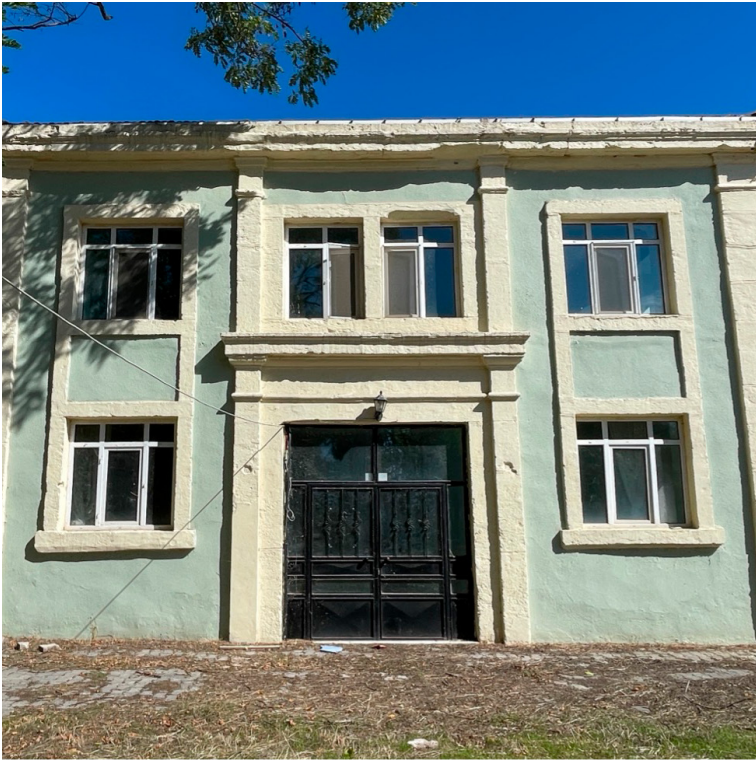
12. Edirne Süvari Kışlası'nın güney kolu ( D bloğunun) batı cephesi
