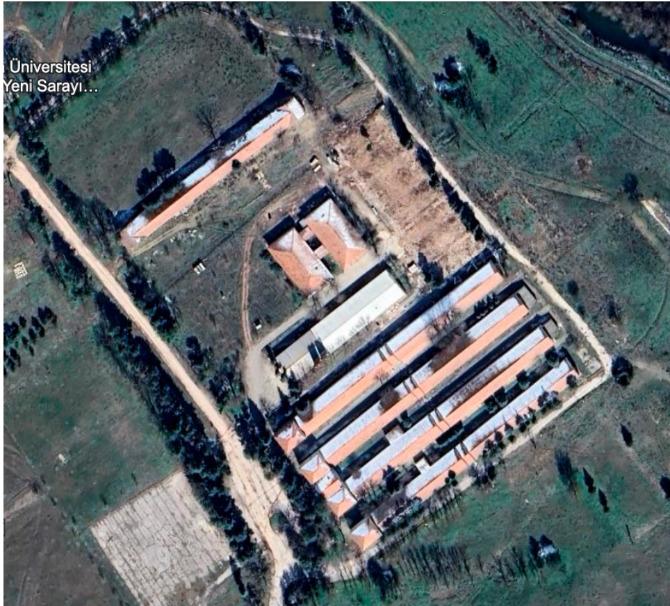
1. Edirne Süvari Kışlası'nın havadan görünümü (Google Earth) (2025)
